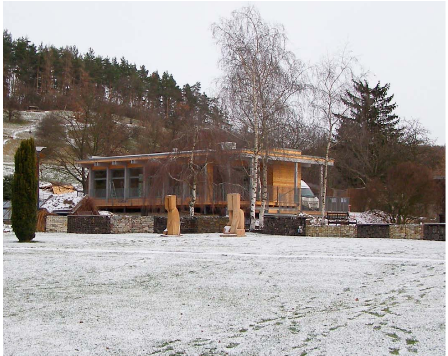
Dřevěný altán – realizace
