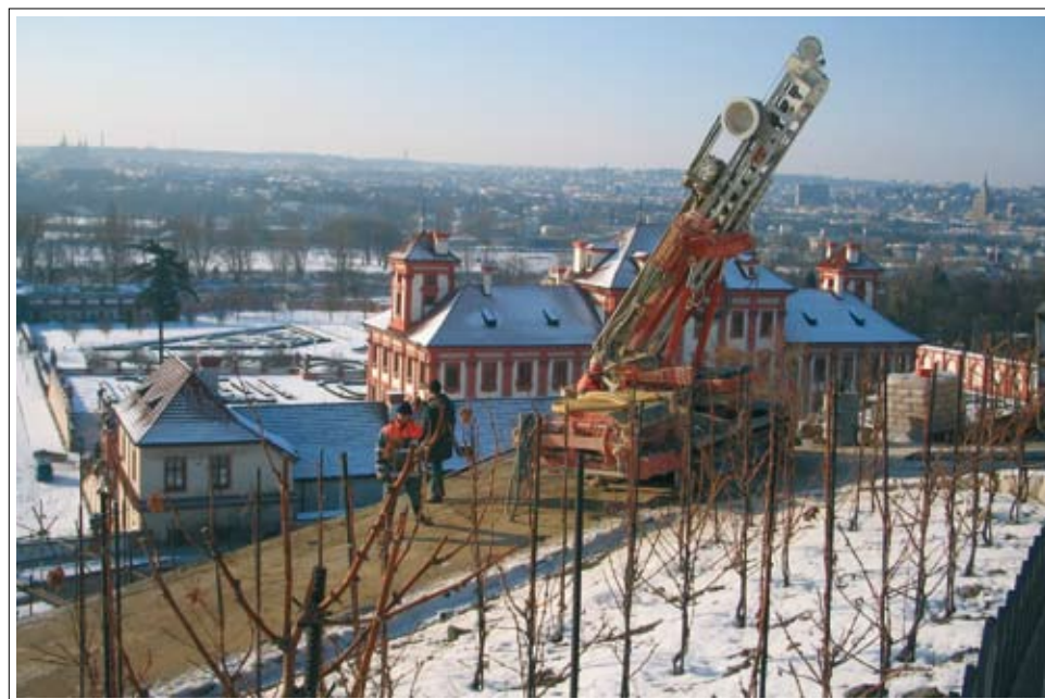
Sanace svahu na Vinici sv. Kláry
