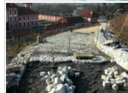
↓ Realizace cesty v západní části vinice
