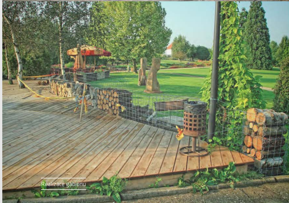
Rekonstrukce potoka v Japonské zahradě
