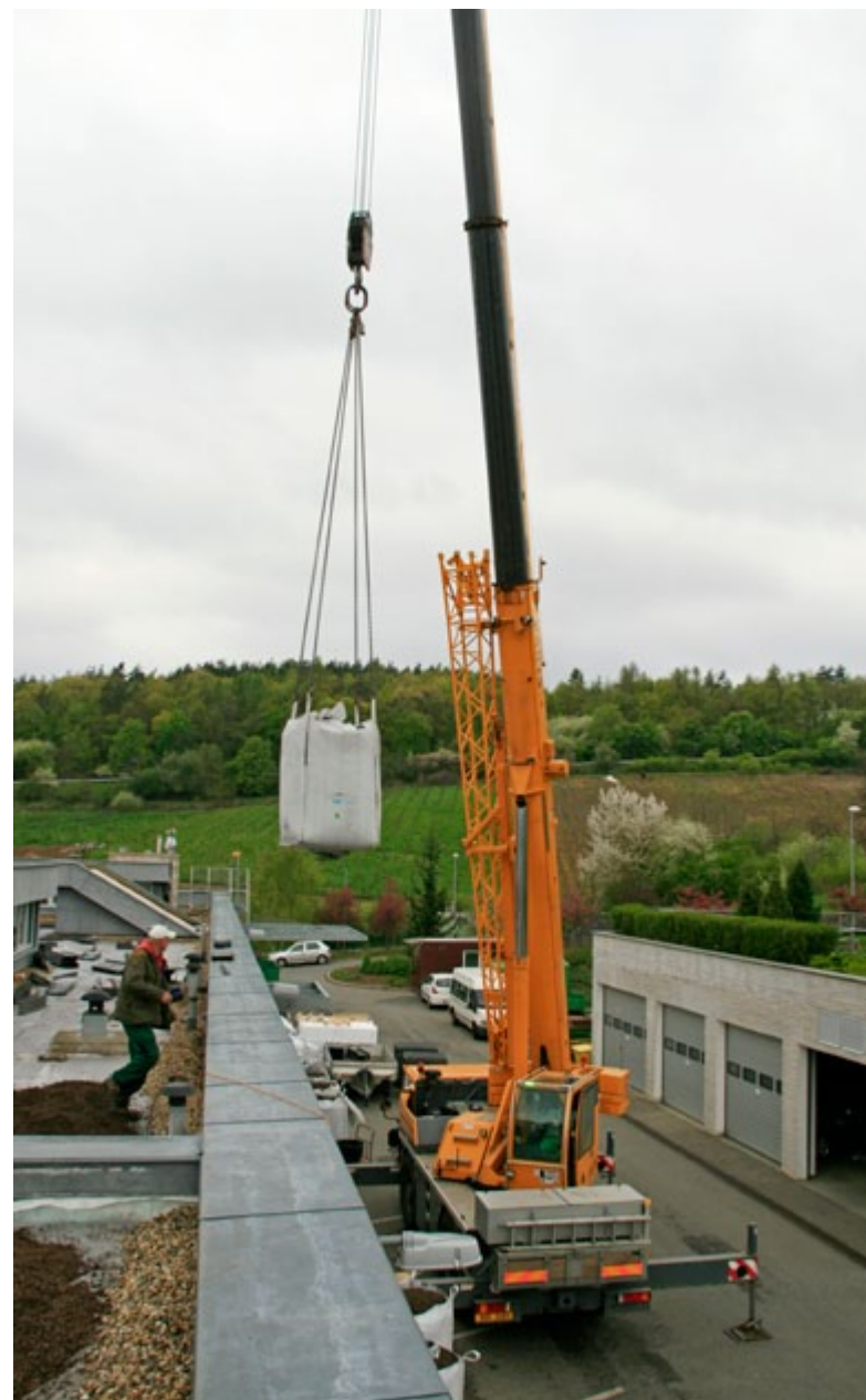
Úprava střechy budovy ředitelství
