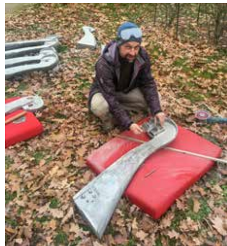
Instalace lesního zastavení v prosinci 2020
