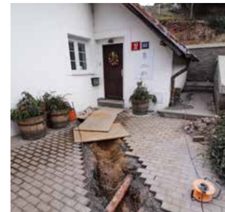
Rekonstrukce kanalizace pro objekt Fokus
