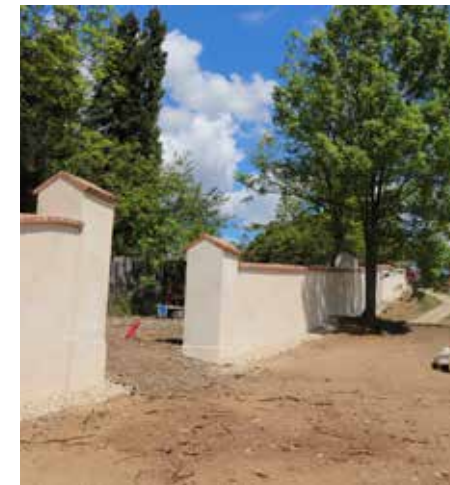
Rekonstruovaná viniční zeď
