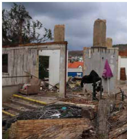
Demolice objektu bývalého ředitelství z roku 1969
